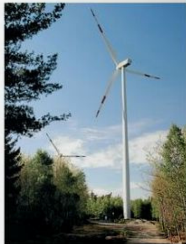
Am Standort „Hainhaus“ befinden sich insgesamt sechs Windkraftanlagen.
