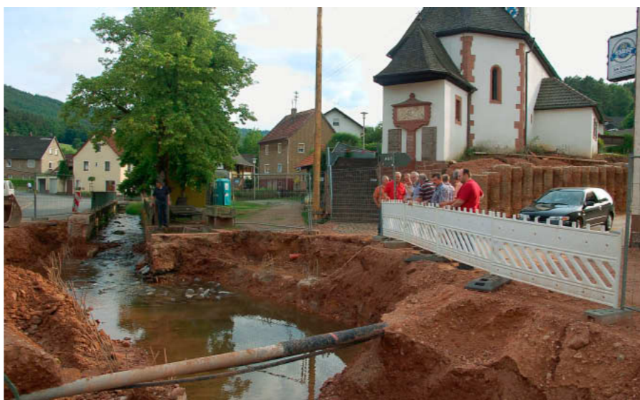
Loch statt Straße: Die Weckbacher Ortsmitte ist derzeit eine Großbaustelle. Bauingenieur Bernd Eilbacher informierte den Gemeinderat über den Stand der Arbeiten. Foto: Franz Miltenberger
