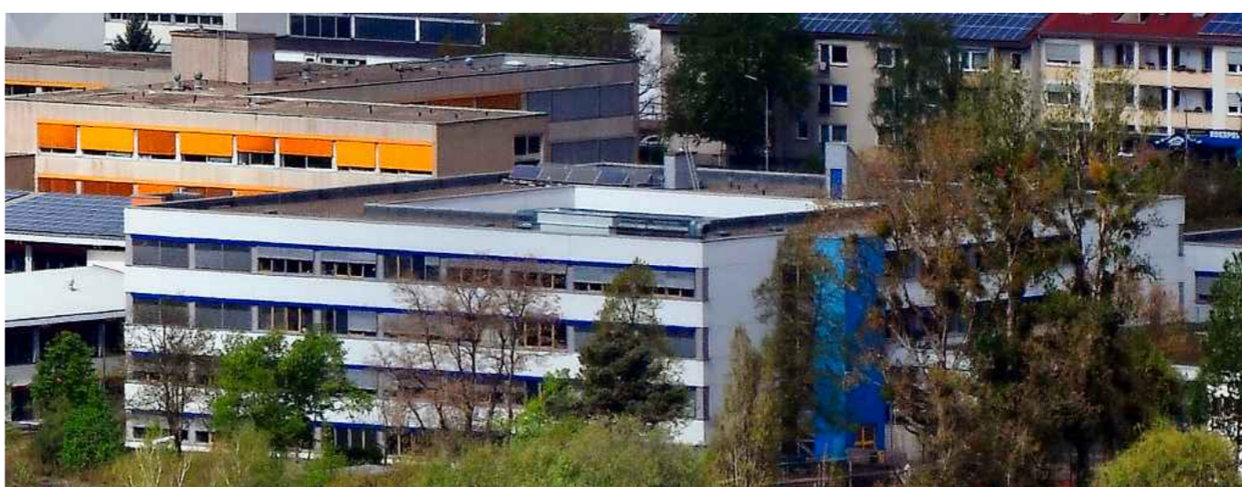
Das erste Projekt der Energiegenossenschaft Untermain: Der Landkreis Miltenberg lässt das Dach der Miltenberger Realschule (im Vordergrund) mit einer Fotovoltaik-Anlage ausstatten. Foto: Winfried Zang
